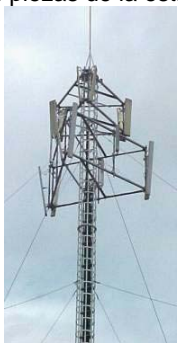
Observa los tirantes que sujetan esta antena
