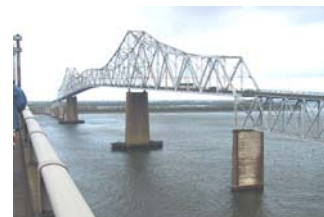
Los pilares están sometidos a un esfuerzo de compresión porque el puente que soportan tiende a _____
