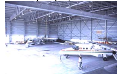
Naves industriales y un hangar cuya cubierta se apoya en cerchas
